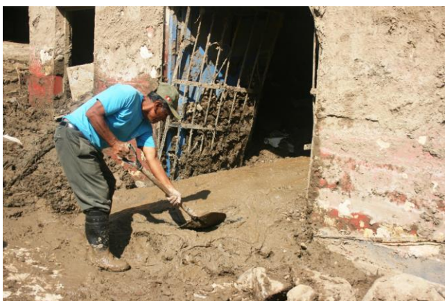
Aufräumarbeiten in Chosica – Lima.
