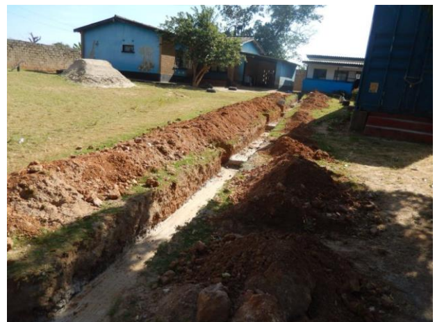
Fundament der Mauer
