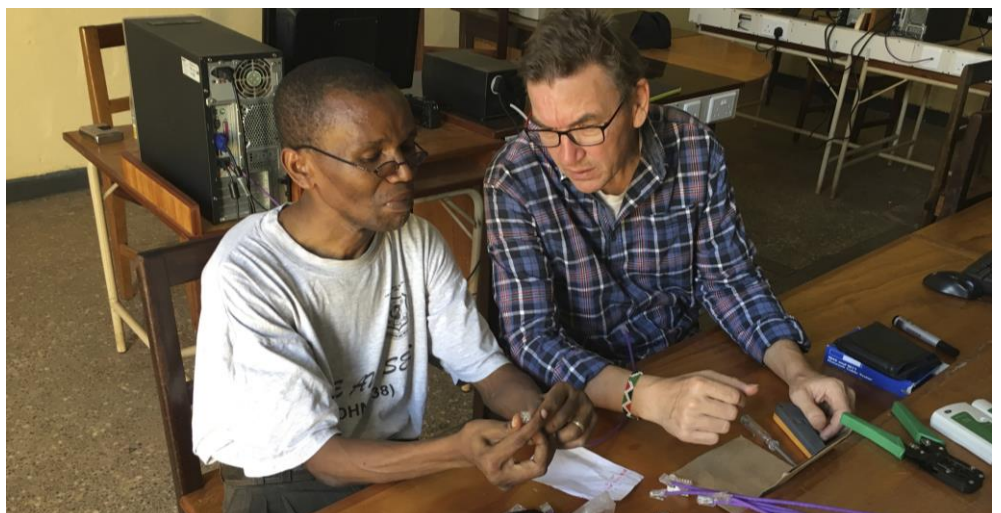
Montage von Steckern auf Netzwerkabel
