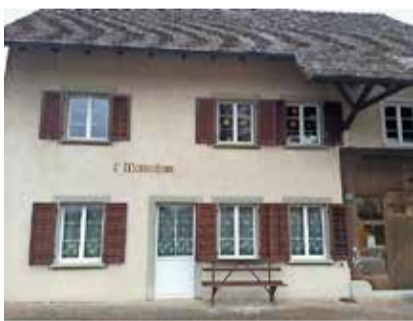
Das Löhninger Mesmerhuus kann dank einer Spende renoviert werden. Bild E. M. M.
